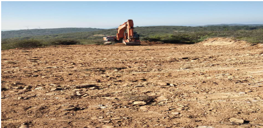
二期修路 工地巡视 20170810
