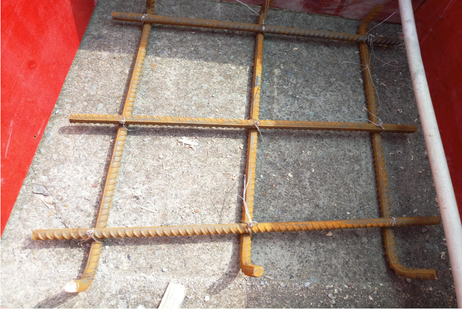
基础钢筋绑扎
