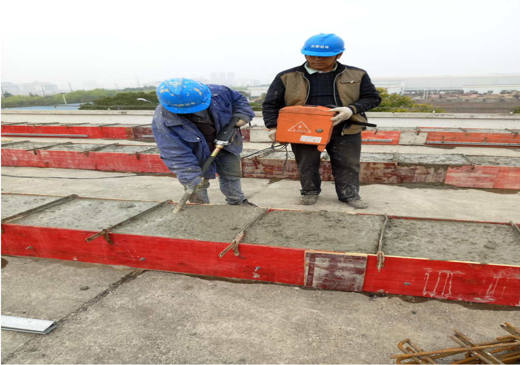
基础浇筑作业。
