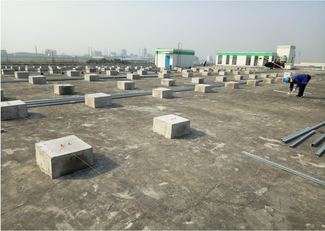
基础定位放线
