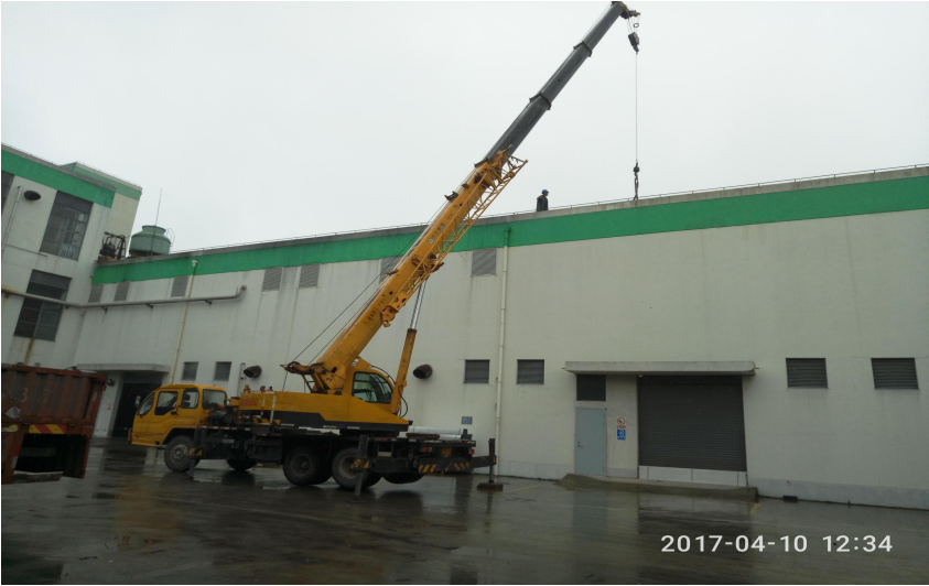
支架吊运作业
