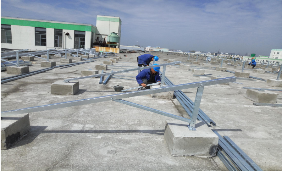
支架安装作业
