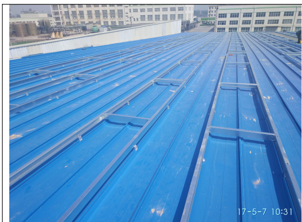
检修车间 2#光伏支架安装
