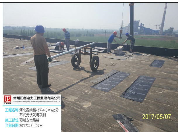
加工车间屋顶混凝土预制支墩吊装就位
