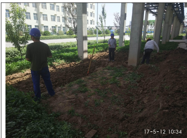
箱逆变基础人工开挖
