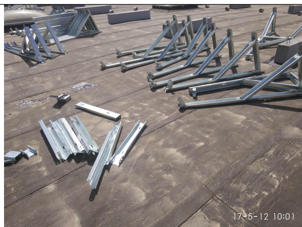
加工车间屋顶支架安装
