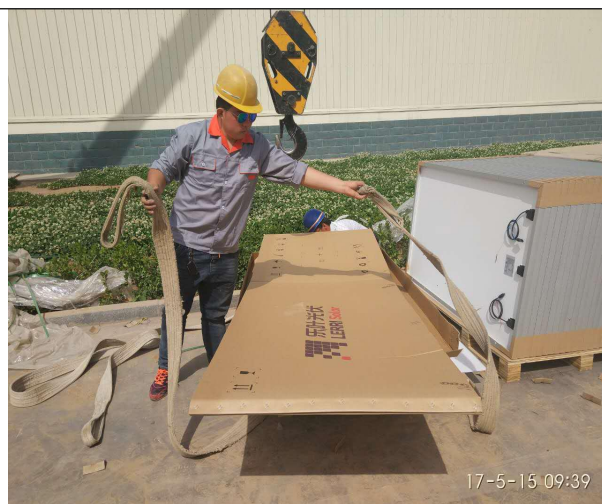
光伏组件开箱、吊装
