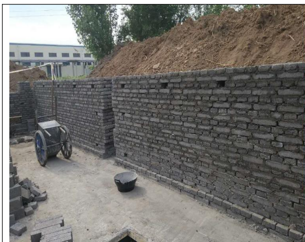
预制仓围墙砌筑
