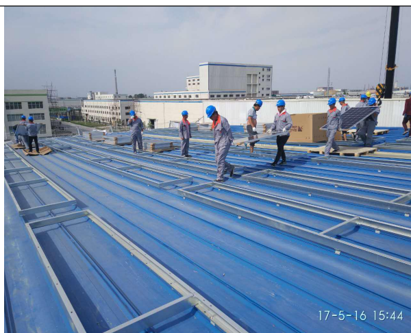
光伏组件开箱、吊装
