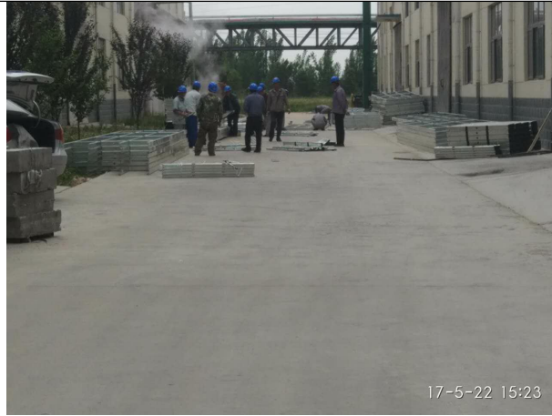
加工车间支架安装
