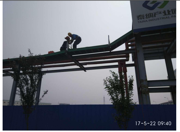
电缆桥架支架焊接
