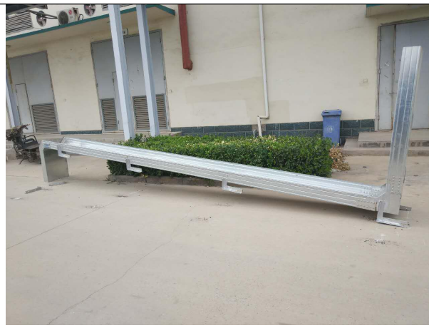
型材主车间立面桥架制作安装
