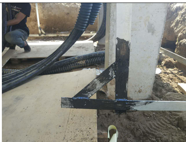
箱逆变接地防腐
