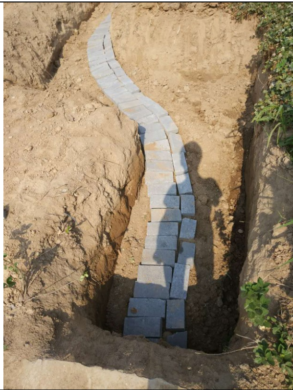
电缆沟电缆直埋
