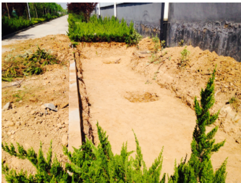
1#箱逆变设备基础基坑验收
