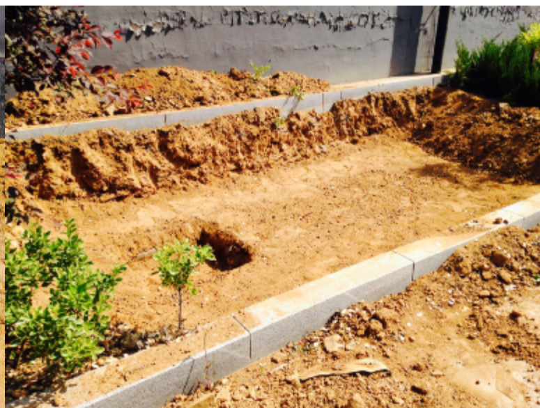
2#箱逆变设备基础基坑验收
