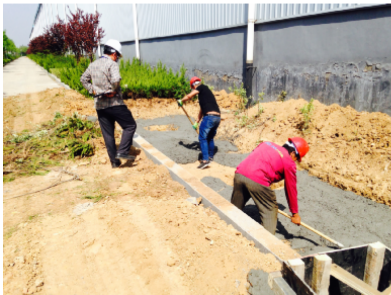
2#箱逆变设备基础基坑验收
