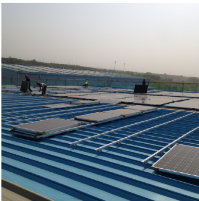
3#屋面组件安装前准备工作
