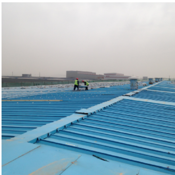
6#仓库屋面组件搬运
