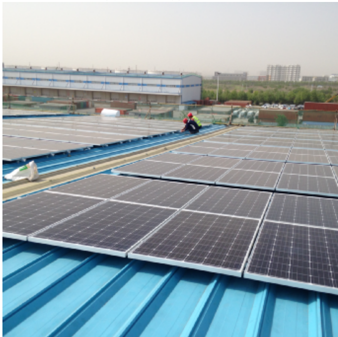
2#仓库屋面组件安装
