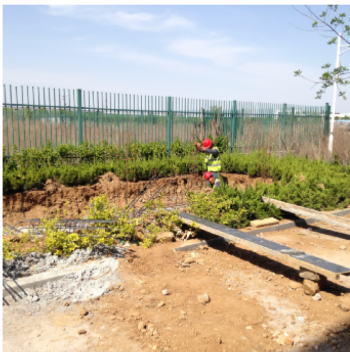
裕龙 4#箱逆变设备基础钢筋施工
