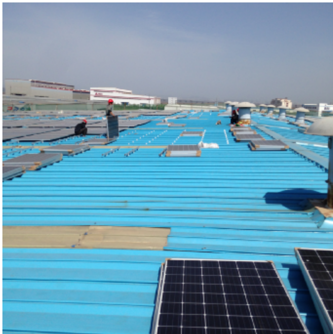
裕龙 6#屋面组件安装
