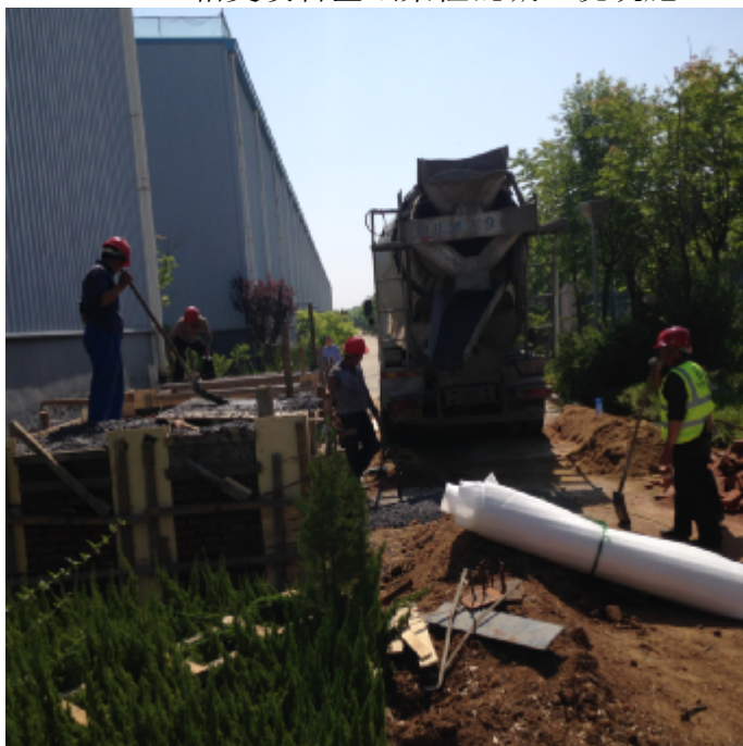
1#箱变设备基础梁柱混凝土浇筑施工
