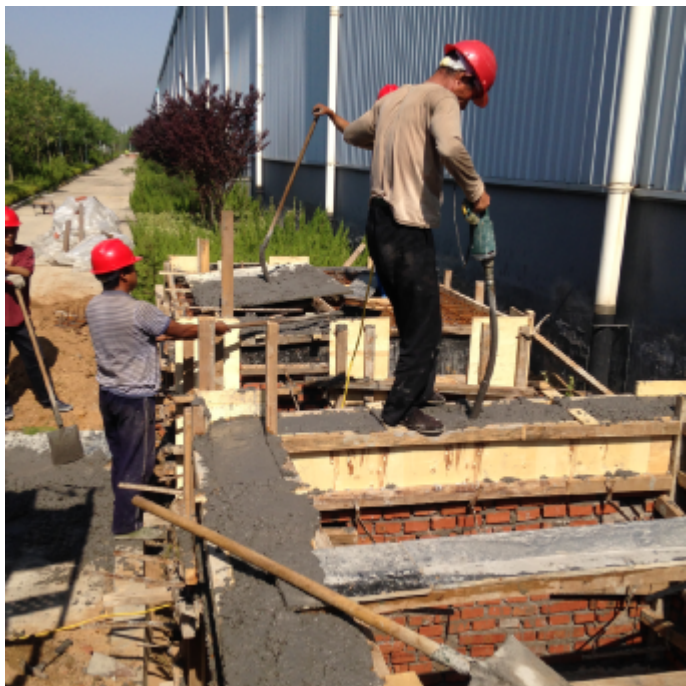
2#箱逆变设备混凝土浇筑时振捣作业
