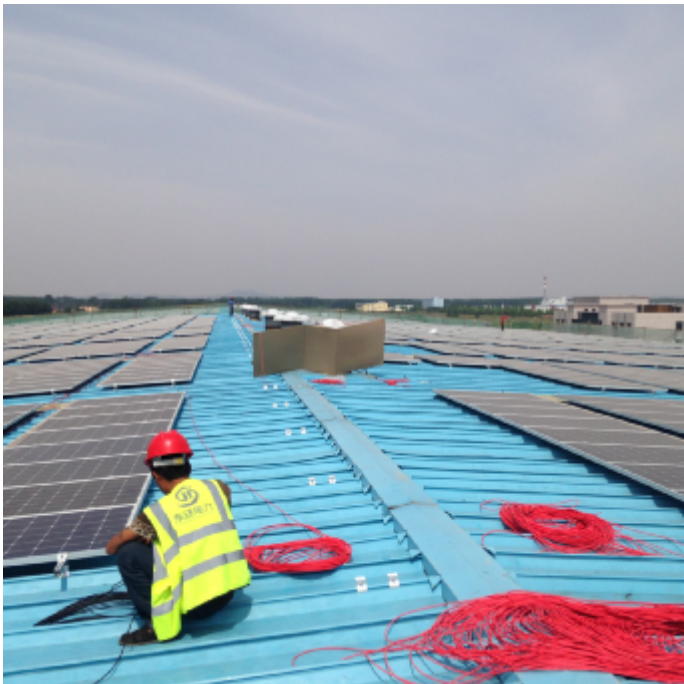
裕龙 2#屋面光伏电缆敷设
