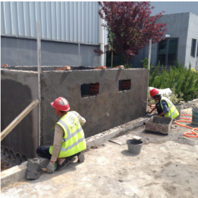
1#箱逆变设备基础墙体抹灰
