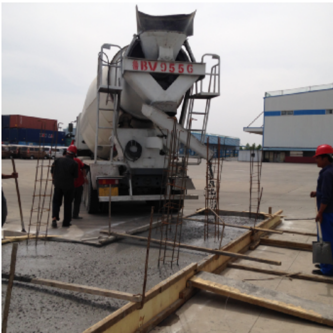
中韩 5#箱逆变设备基础底板混凝土浇筑施工
