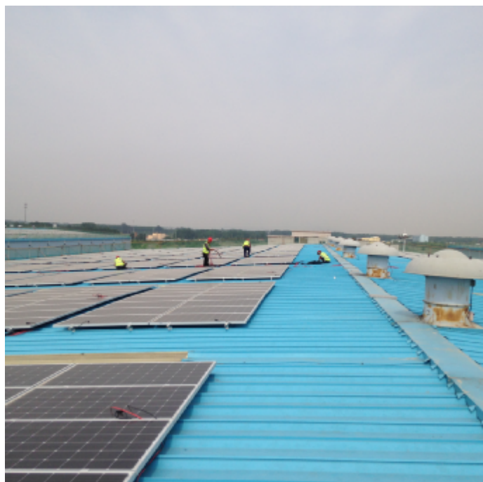
裕龙 3#屋面光伏电缆敷设
