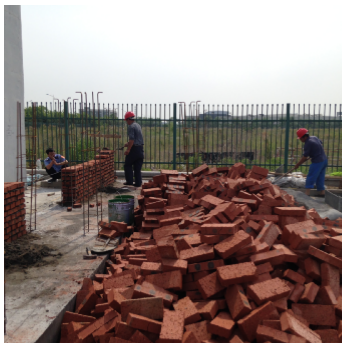
中韩 5#箱逆变设备基础墙体砌筑
