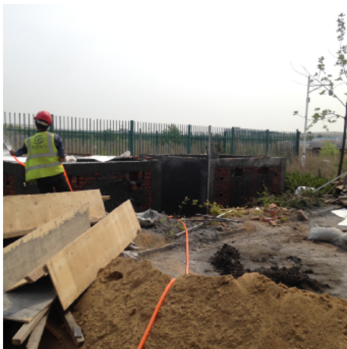
4#箱逆变设备基础墙体抹灰
