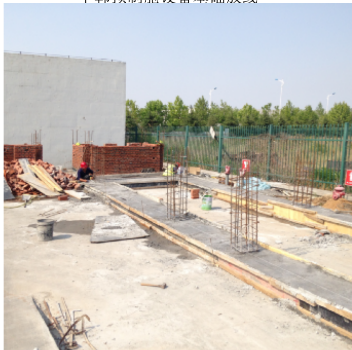
中韩预制舱设备基础放线
