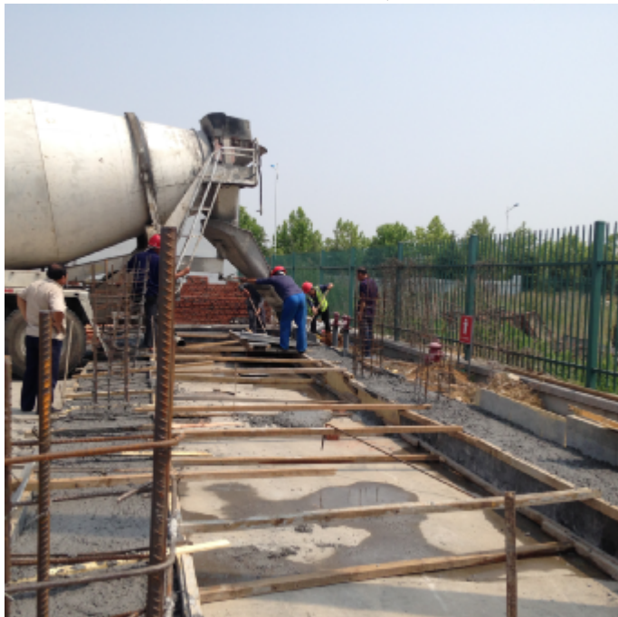
中韩预制舱设备基础底板混凝土浇筑
