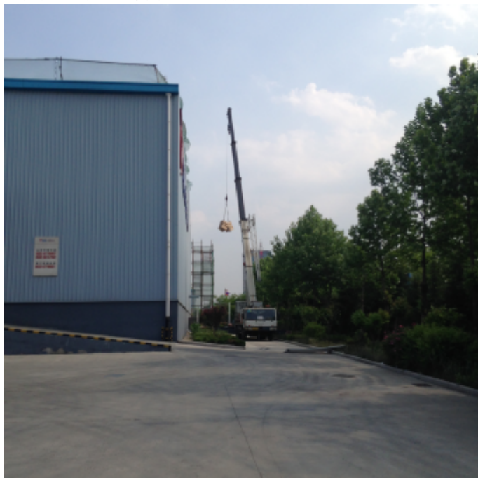
中韩 2#屋面材料吊运作业
