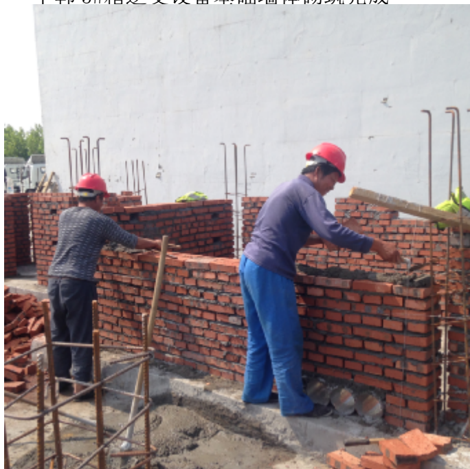
中韩 5#箱逆变设备基础墙体砌筑完成
