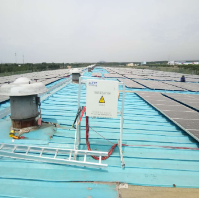
裕龙 1#屋面汇流箱试安装
