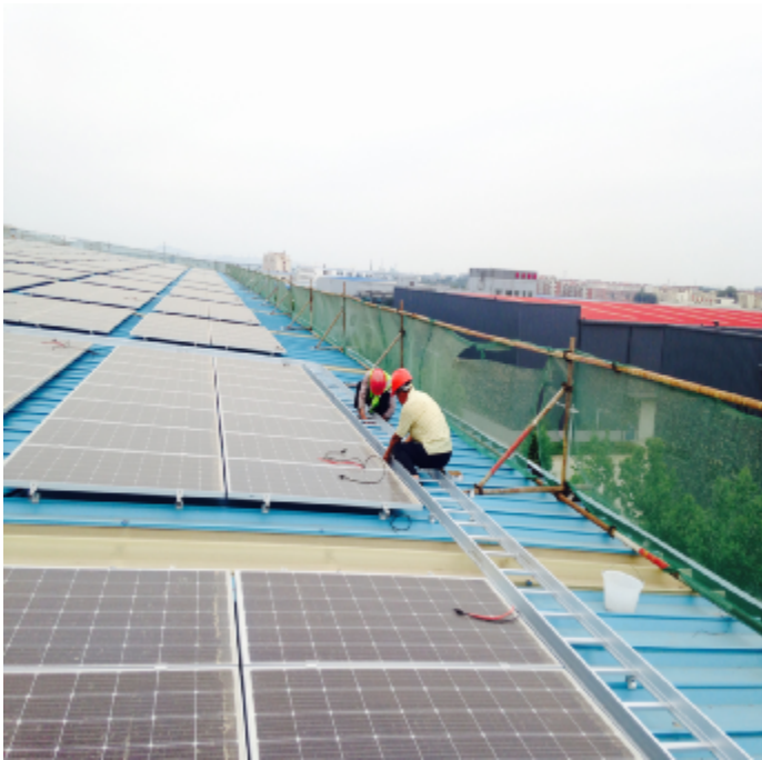
裕龙 6#屋面电缆桥架安装
