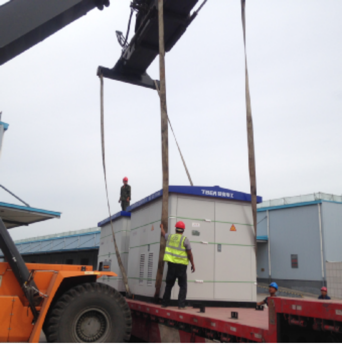
箱逆变设备吊运卸货
