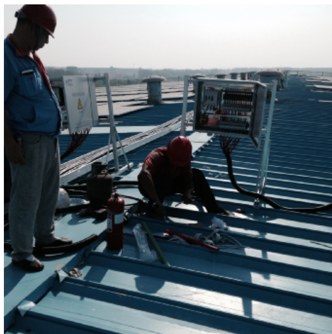
中韩 2#屋面直流电缆头制作安装
