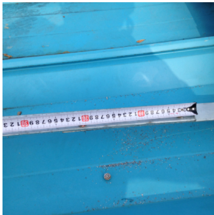
检查裕龙 6#屋面接地螺栓连接搭接长度
