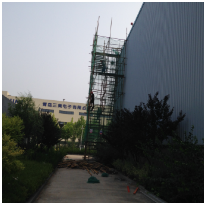
裕龙 1#屋面钢管运输
