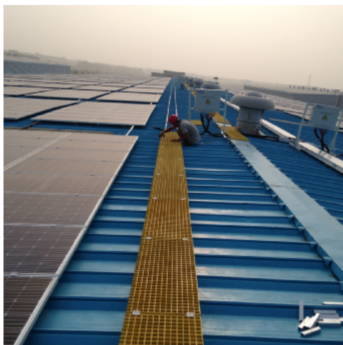
裕龙 3#屋面铺设运维通道防滑格栅
