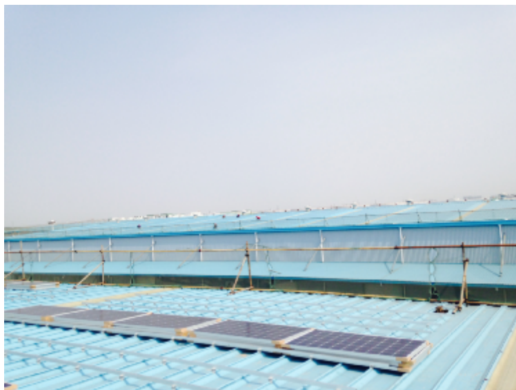
2#厂房组件堆放（每 4 块组件一堆）
