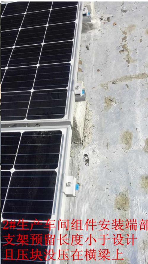
2#生产车间下滑的配重基础重新浇筑
