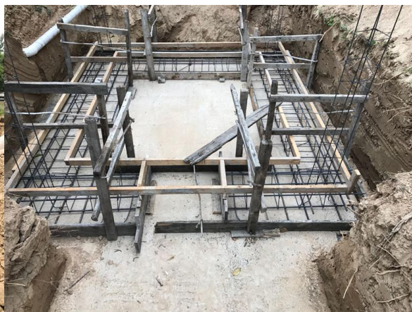
拉丝车间配重基础浇筑
