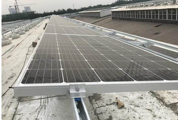
压扁胶排组件安装
