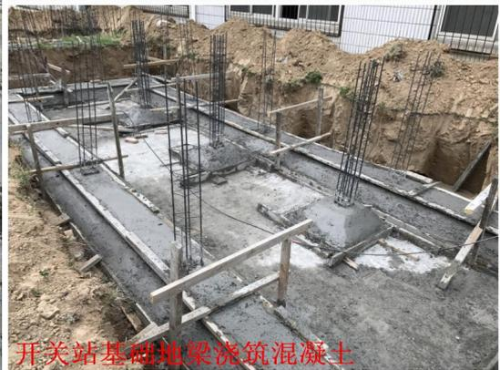
开关站基础地梁浇筑混凝土
