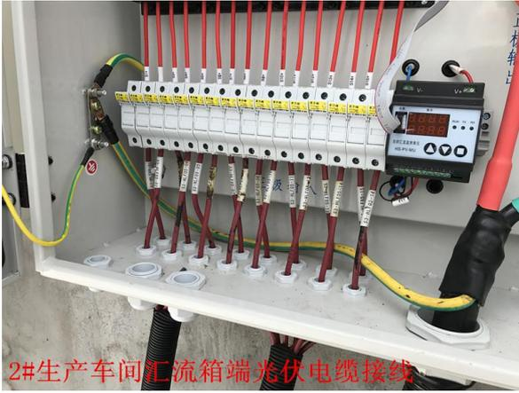
2#生产车间汇流箱端光伏电缆接线
