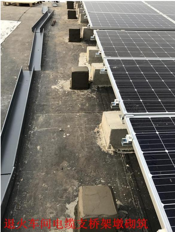
退火车间电缆支桥架墩砌筑
