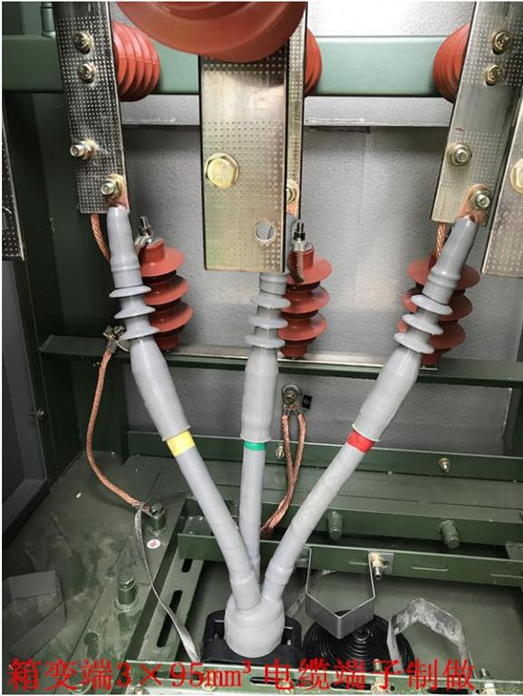
箱变端 $3 \times 95\text{mm}^2$  电缆端子制做
