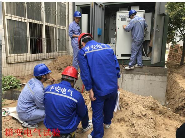
箱变电气试验
