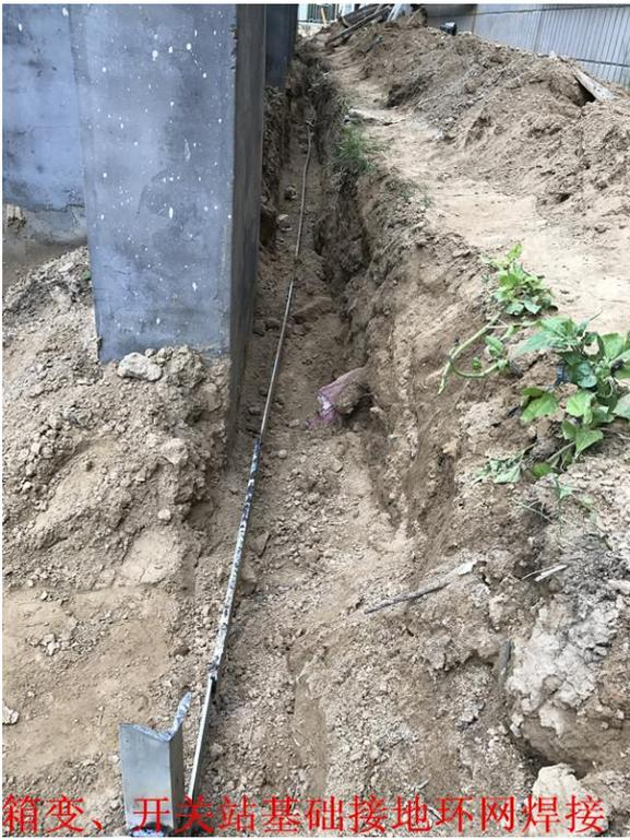
箱变、开关站基础接地环网焊接
