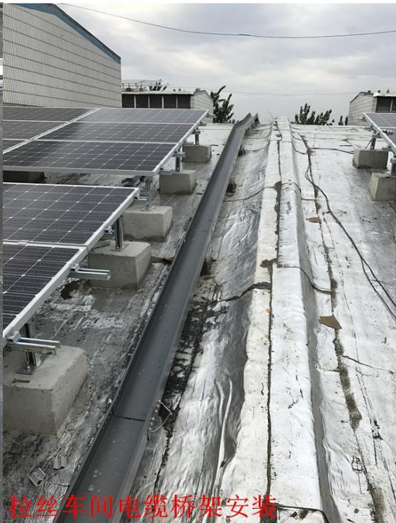
拉丝车间电缆桥架安装
