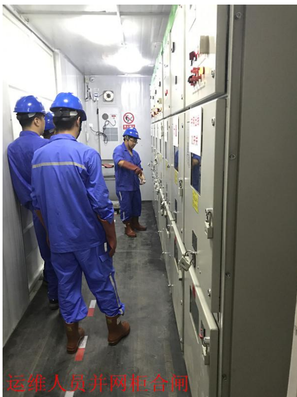
合闸前检查箱变高压侧是分开状态
