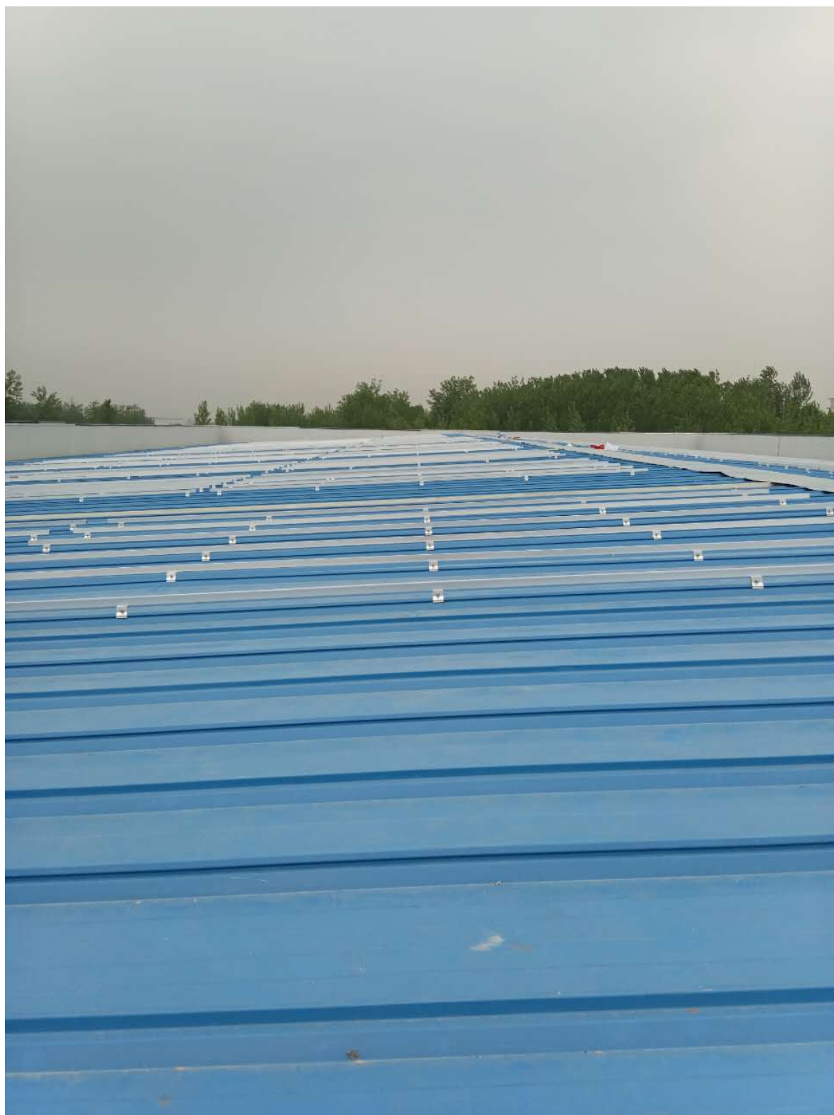
1#屋面支架完成
