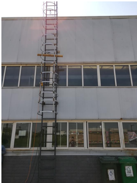
数控车间爬梯焊接
