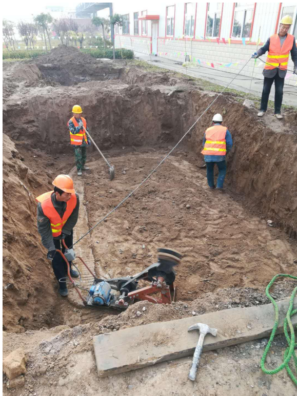
三七灰土换填及打夯
