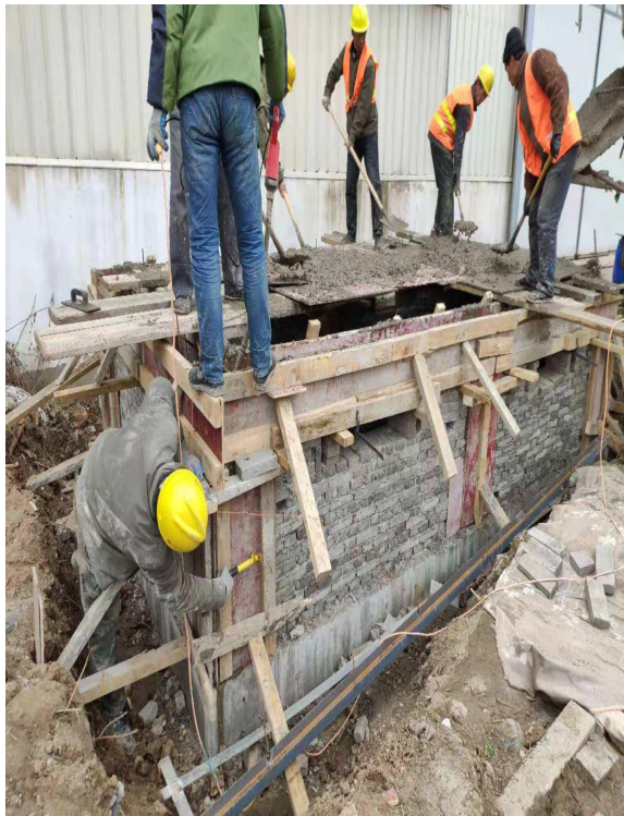
箱逆变基础浇筑
