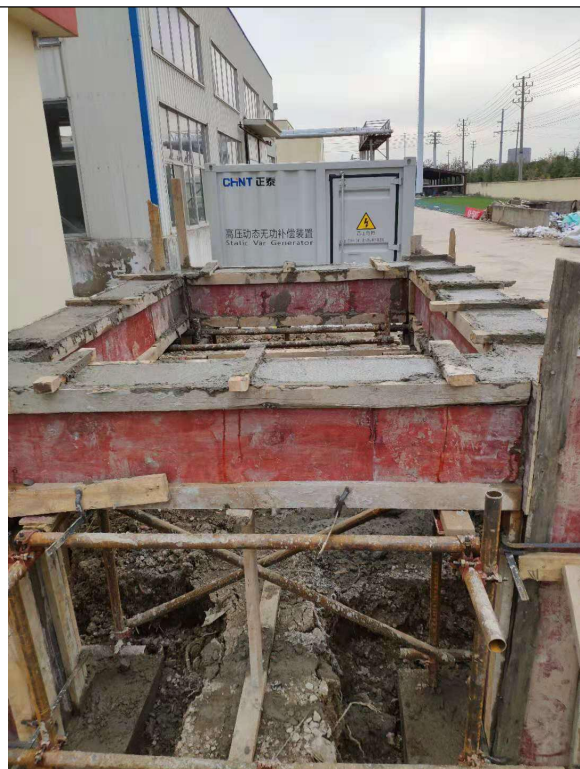
SVG 框架梁浇筑
