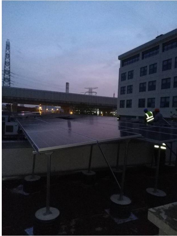
2. 完成安装 608 块组件（已完成）
