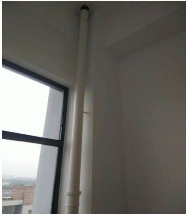
2. 完成更换 9 号楼下水管道（已完成）
