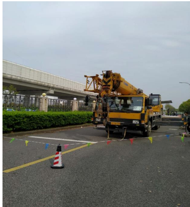
1、完成组件吊装（已完成）
