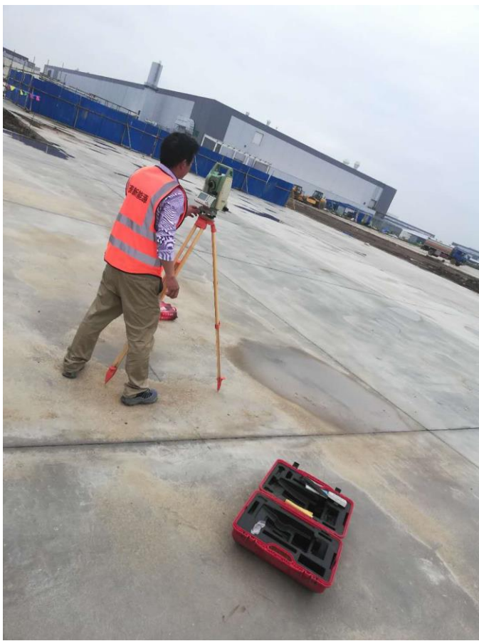
西区车棚定位放线全站仪复测
