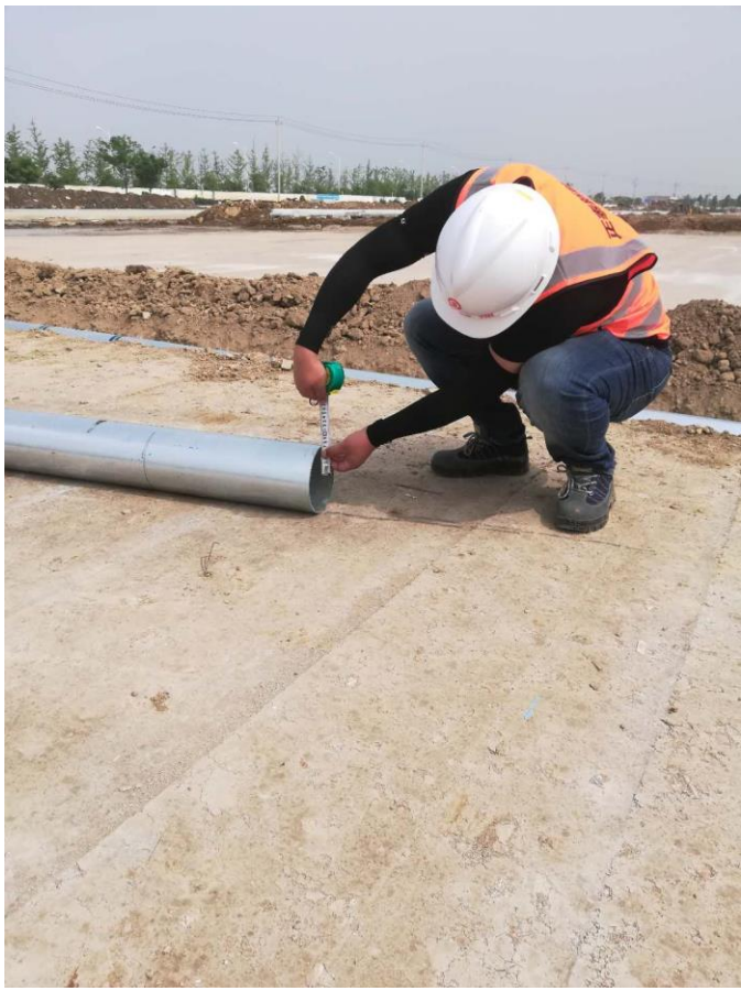
检查东区下穿马路电缆套管壁厚
