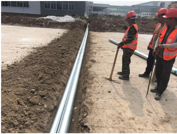
检查东区下穿马路电缆套管直径
