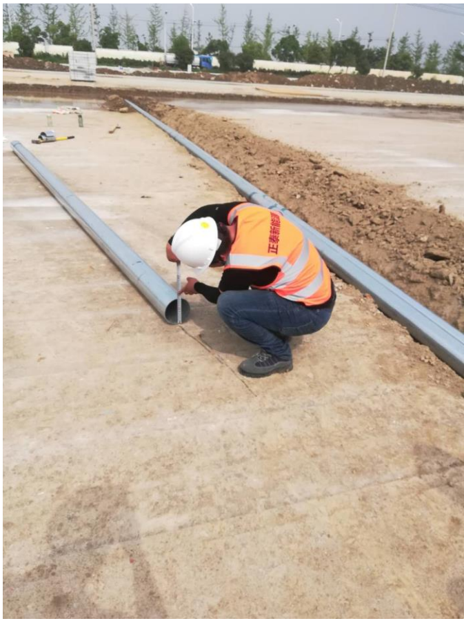
检查东区下穿马路电缆套管直径
