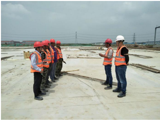
现场施工人员安全交底
