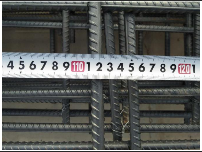
车棚基础钢筋间距不符合要求
