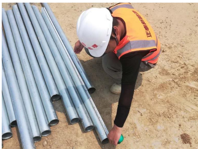
65 接地用钢管切割长度检查
