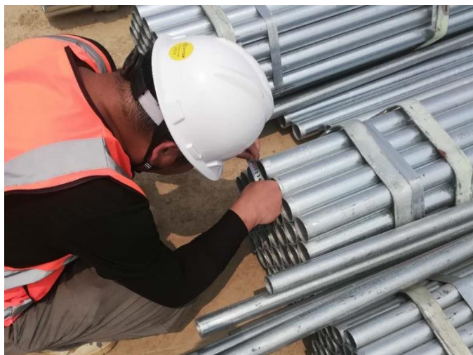
65 接地用钢管切割长度检查
