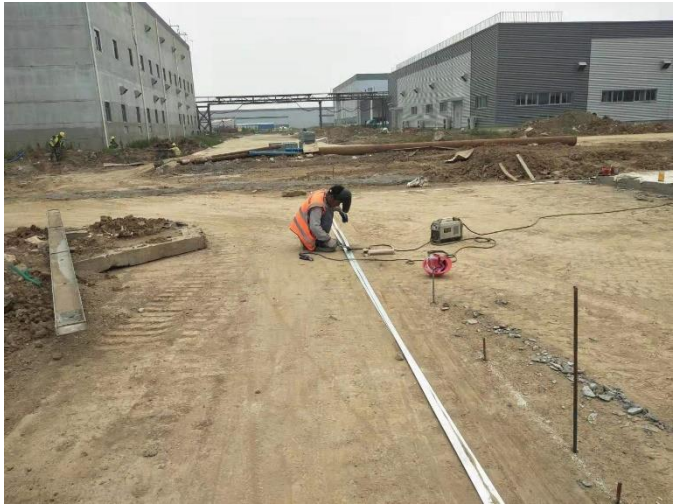
西区车棚水平接地体焊接
