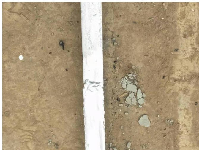
水平接地体埋深不足（图纸 0.8m，实测 0.35m）
