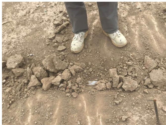
水平接地体埋深不足（图纸 0.8m，实测 0.35m）
