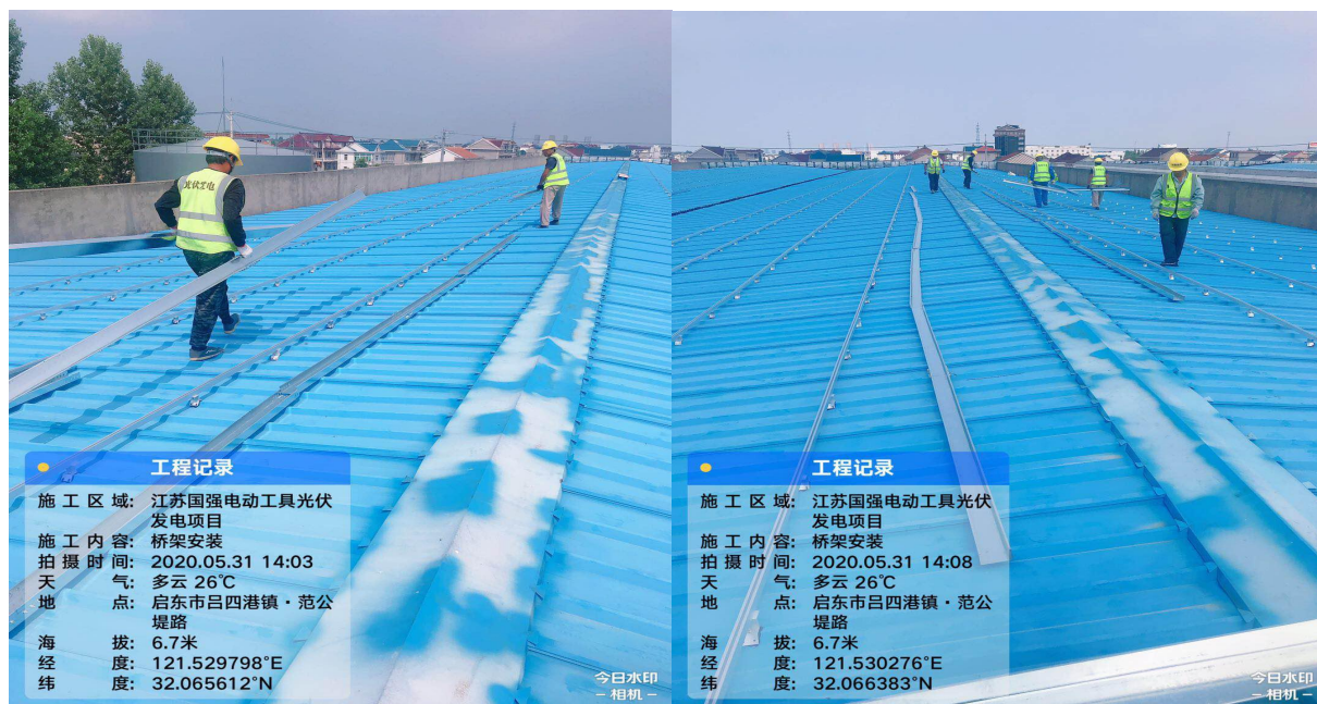
施工现场影像
