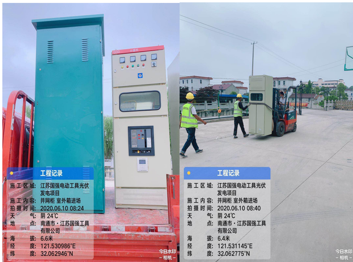
施工现场影像
