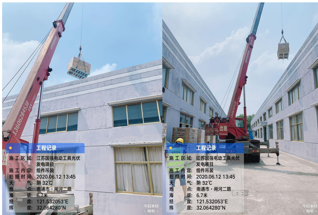
施工现场影像
