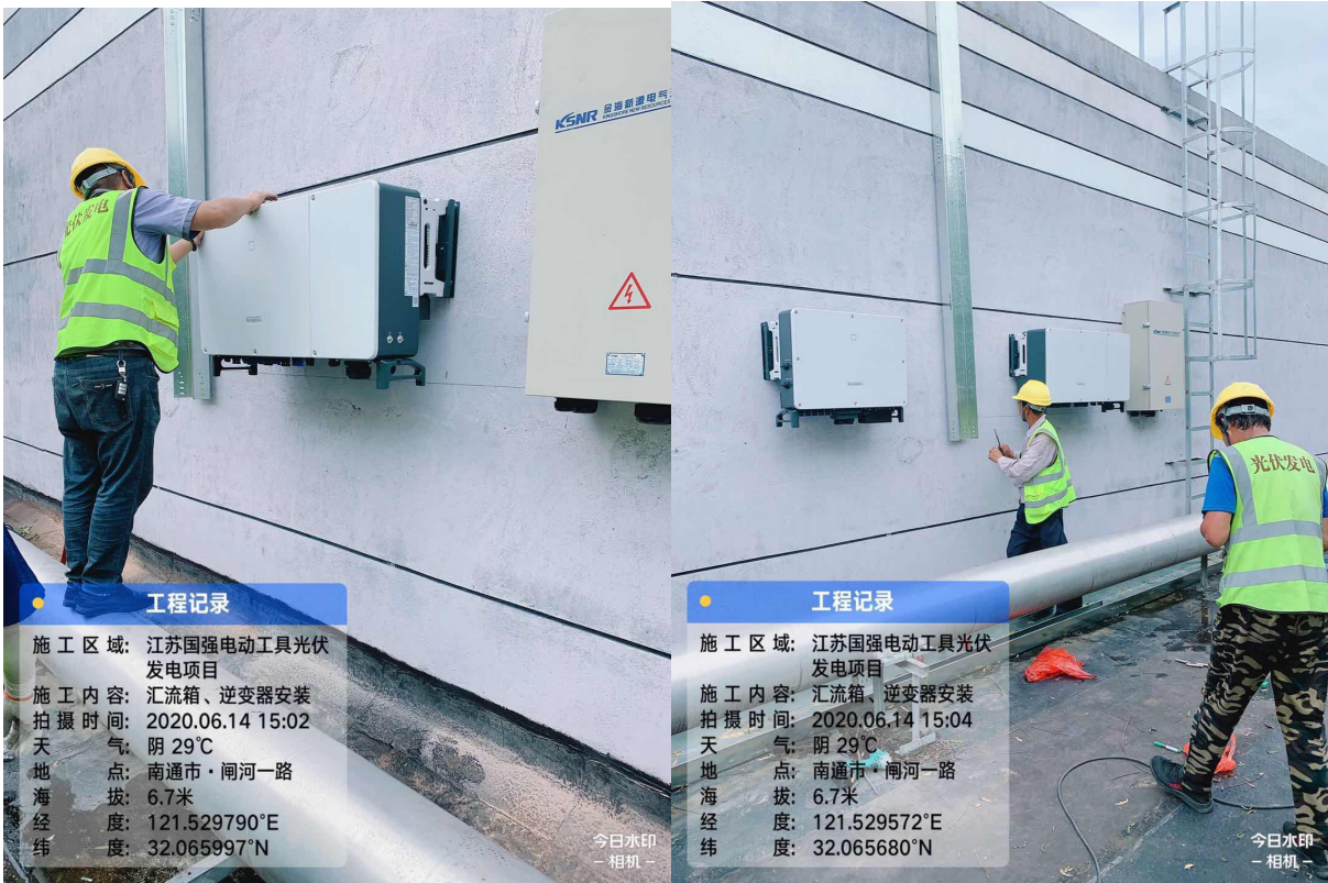
施工现场影像
