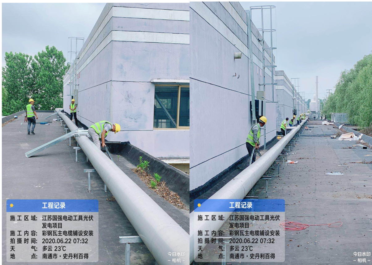
施工现场影像
