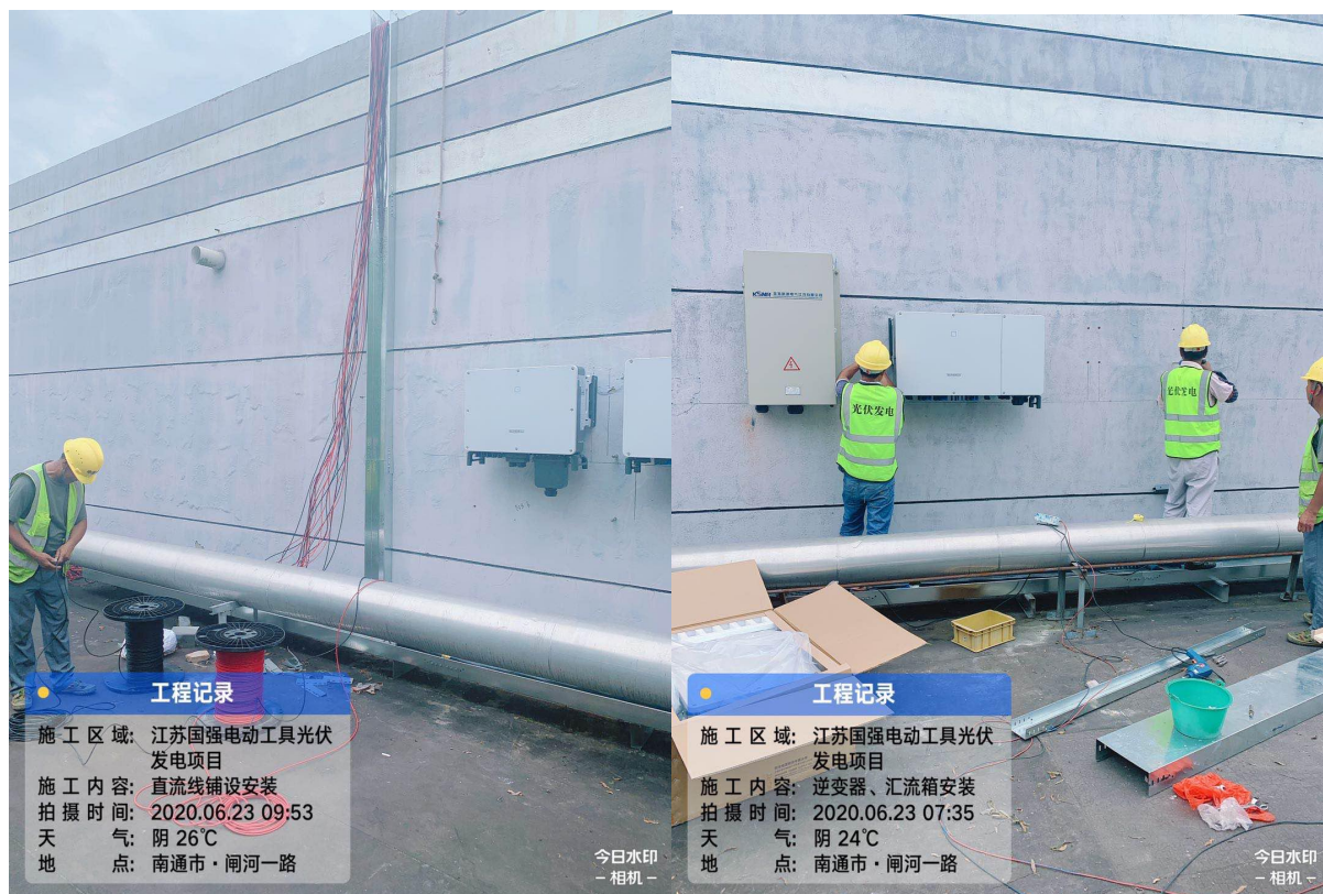
施工现场影像
