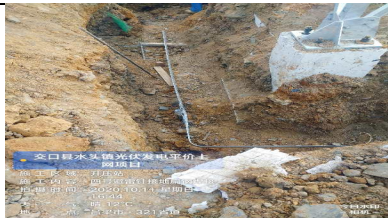
7、关键工序旁站照片：
